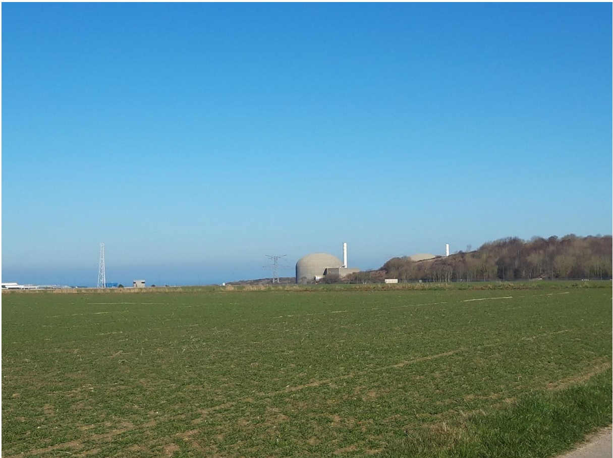
Vue de la Centrale de Paluel du Clos des Fées
